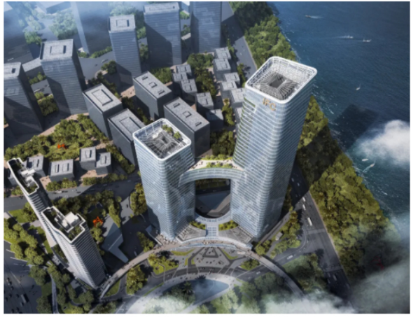
项目地块项目前视图
