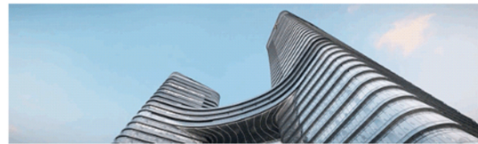
羽翼化层叠处理的玻璃幕墙形成磅礴之势
